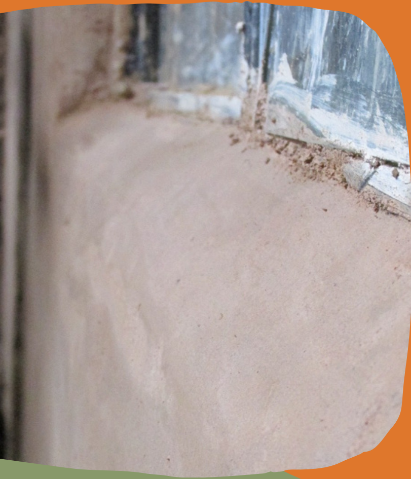
ACABADO FINO DE INTERIOR
